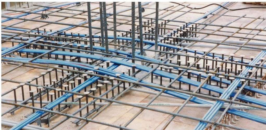
擴頭剪力釘型 剪力鋼筋
