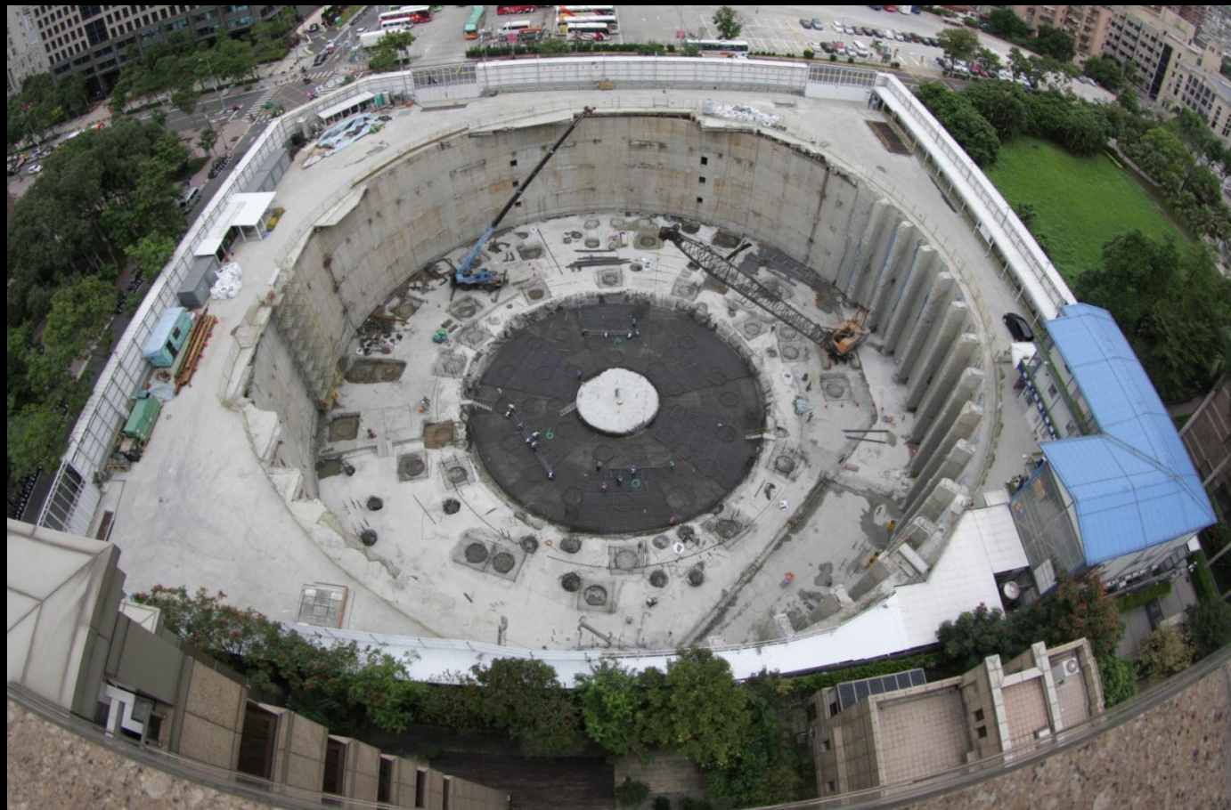
工地施工照片
